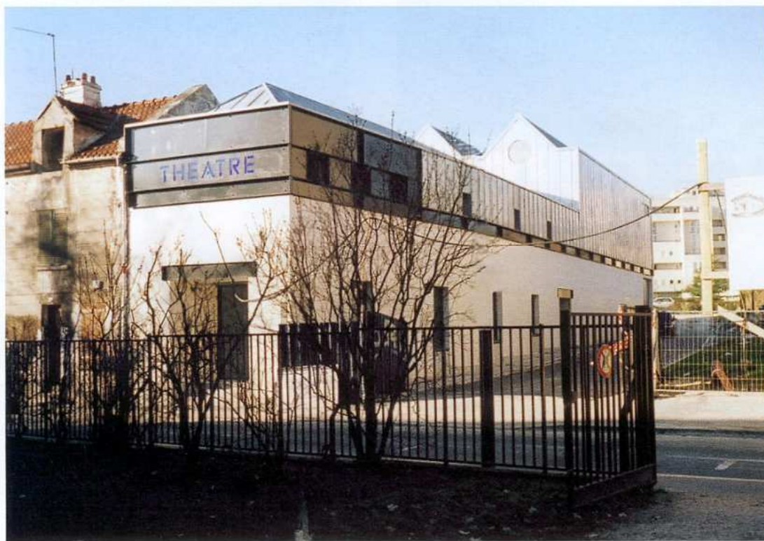
Vue extérieure générale - Photo Philippe Pumain
